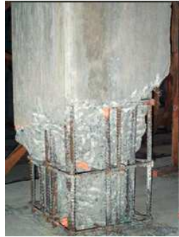
Hormigón Deteriorado
